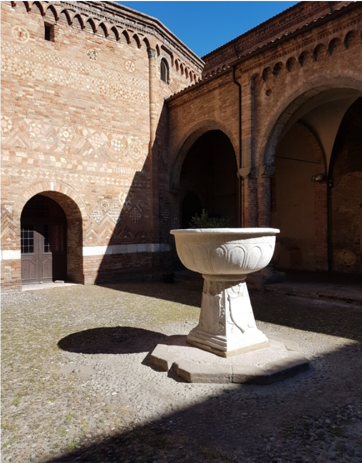
Dopo il restauro
