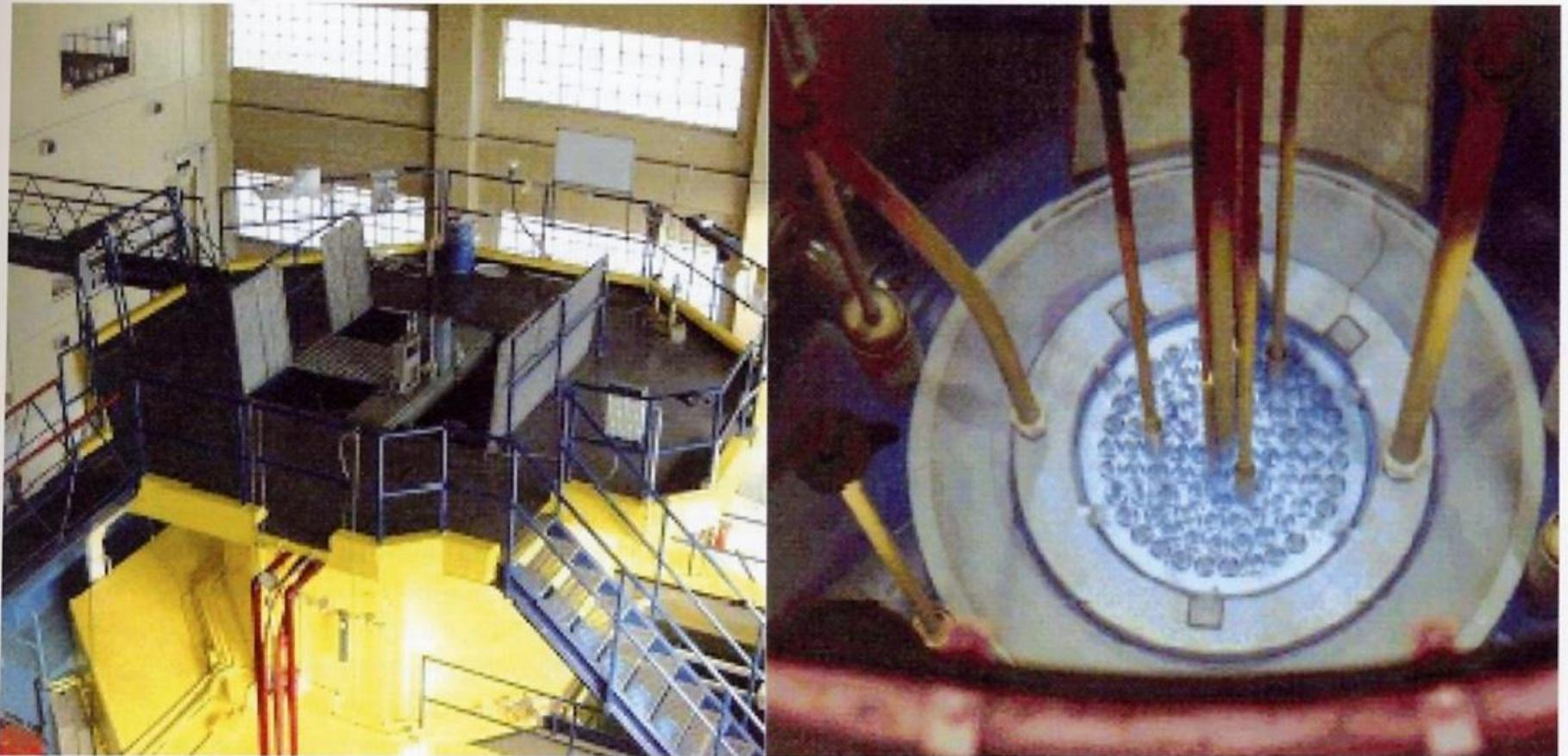
Fig. 5 Il reattore nucleare TRIGA Mark II dell'Università di Pavia. A destra dettaglio del nocciolo.
