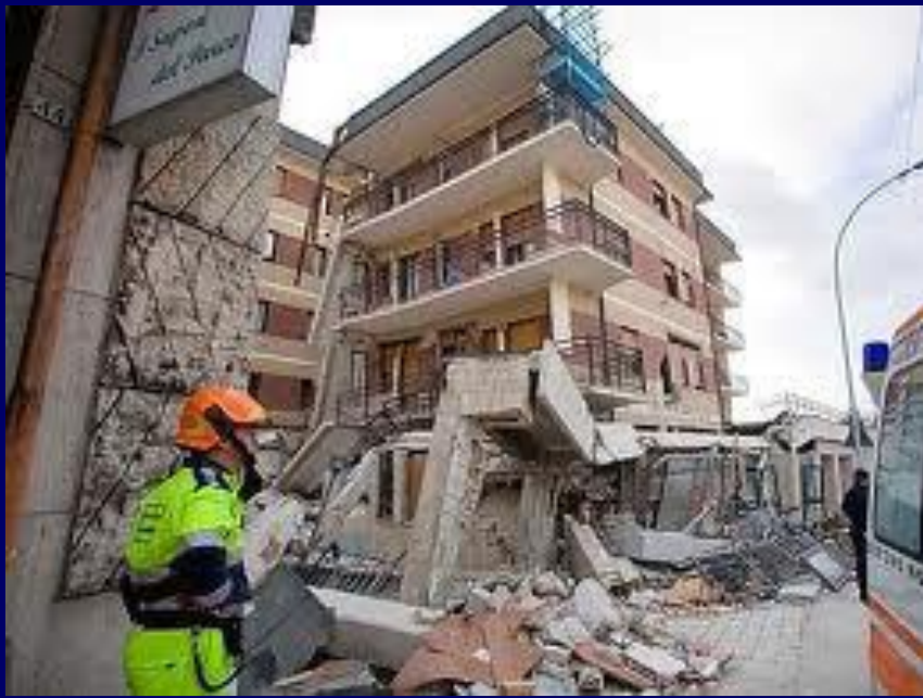
↑ Collasso della “Casa dello Studente” a L’Aquila durante il terremoto del 6 aprile 2009 (M = 6,2)
