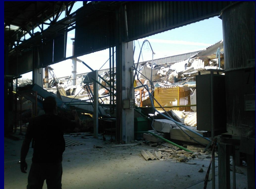
Collasso del capannone industriale della “Ceramica Sant’Agostino” a Sant’Agostino (FE) durante il terremoto dell’Emilia del 20 maggio 2012 (M = 5,9) →
